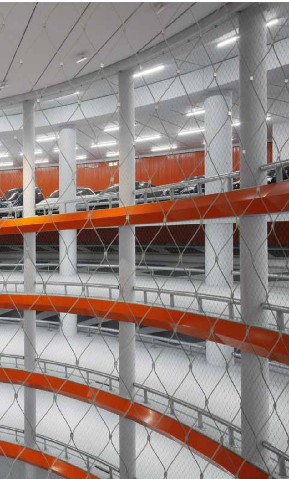
I-SYS Edelstahlseile und X-TEND Seilnetze sind eine leichte und transparente Möglichkeit der Absturz-sicherung. Durch die hohe Transparenz ist eine flächendeckende Sicherung ohne oder mit nur geringer Einschränkung der Sicht sowie Lichtdurchlässigkeit möglich. Durch das geringe Gewicht können sie im Gegensatz zu massiven Gebäudeverkleidungen auch in der Leichtbauarchitektur angewendet werden.
