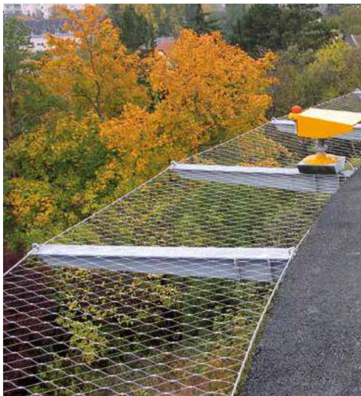
Stehende Masche_Vertical mesh diamond direction
