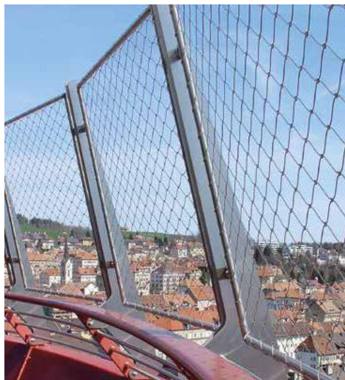
Liegende Masche_Horizontal mesh diamond direction
