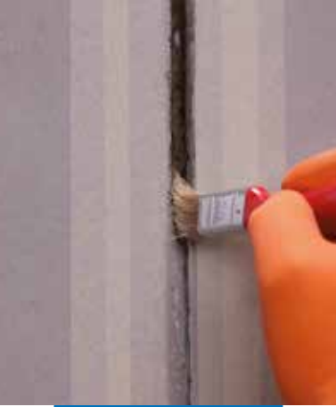
Application of Primer M or Primer A
